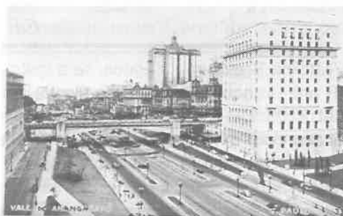
Postal de 1945, com estacionamento no centro do Vale do Anhangabaú.
